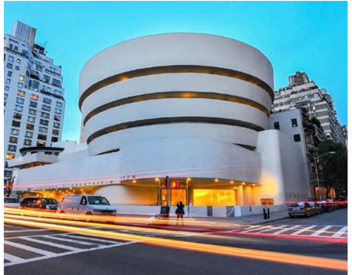
Iluminación Guggenheim Museum Nueva York, EUA
